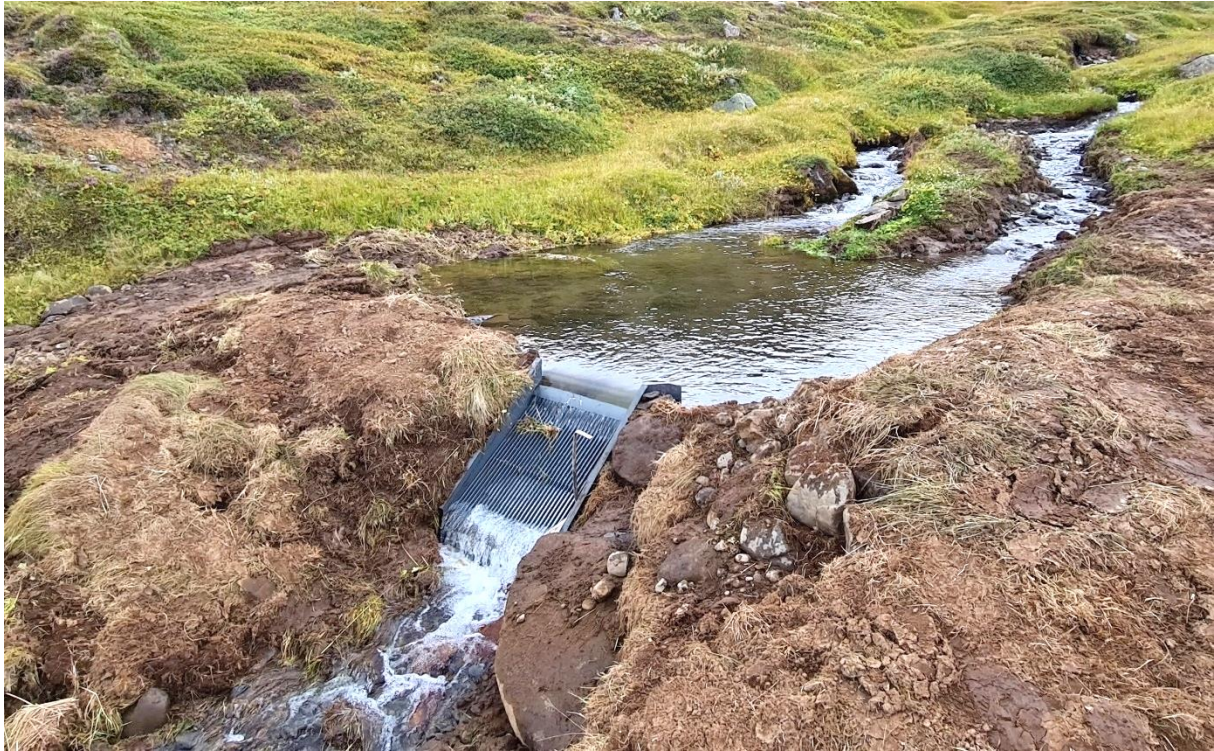
MYND 2.7 Inntaksrist í Fosslæg sem er hliðarinntak Glerárvirkjunar í Eyjafirði. Útfærslan á inntakinu verður aðlöguð að Lambadalsánum en verður sambærileg því sem má sjá á þessari mynd.
