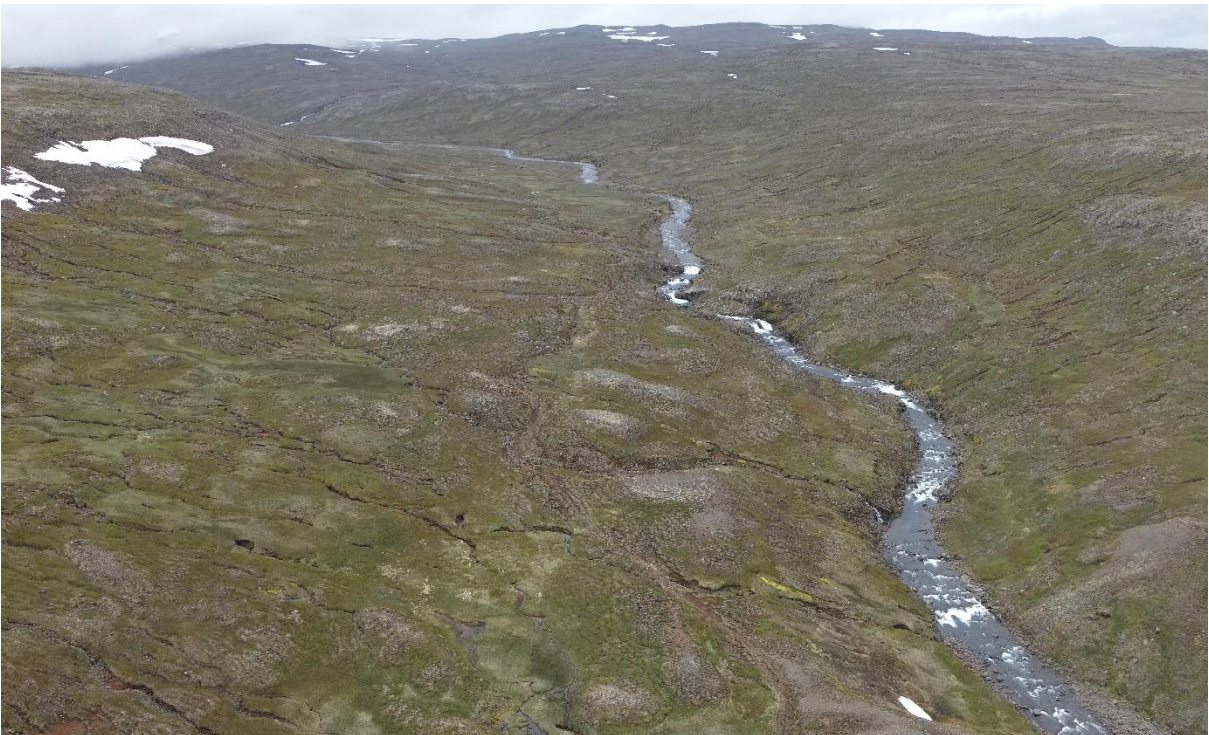
MYND 3.3 Horft upp Gilsárdal. Fyrirhugað stíflustæði er skammt ofan fossanna fyrir miðri mynd.
